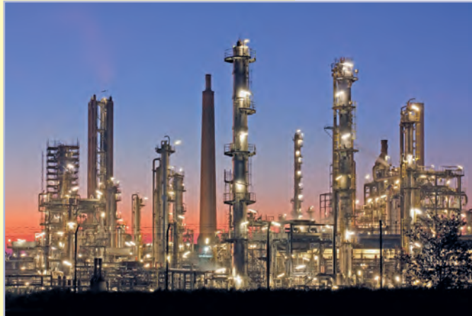
Bild 1: Industrieanlage mit nächtlicher Beleuchtung
